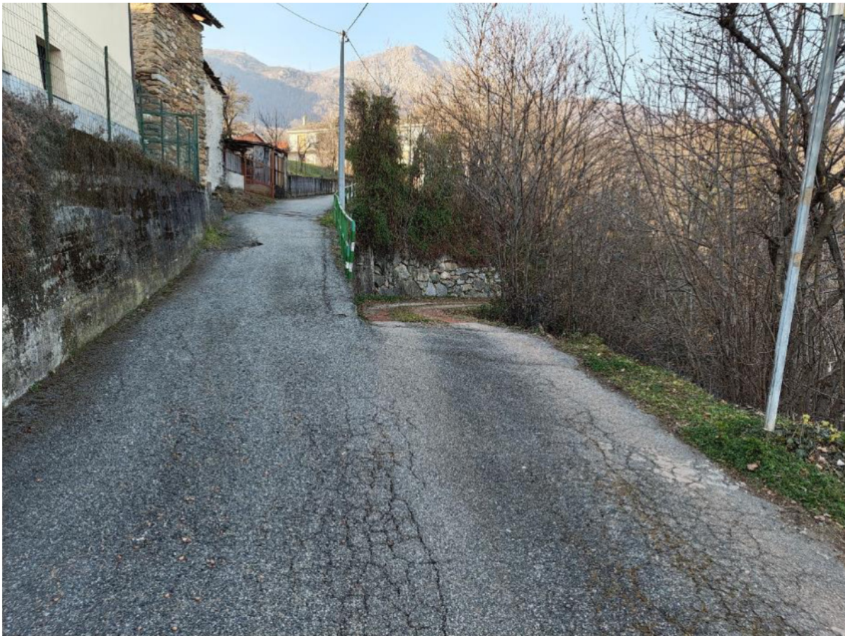
Figura 8: Vista stato attuale dell'area di intervento 9 – allargamento rampa con realizzazione muro di sottoscarpa in c.a. e realizzazione scogliera di valle in massi a secco – Via Santa Elisabetta.
